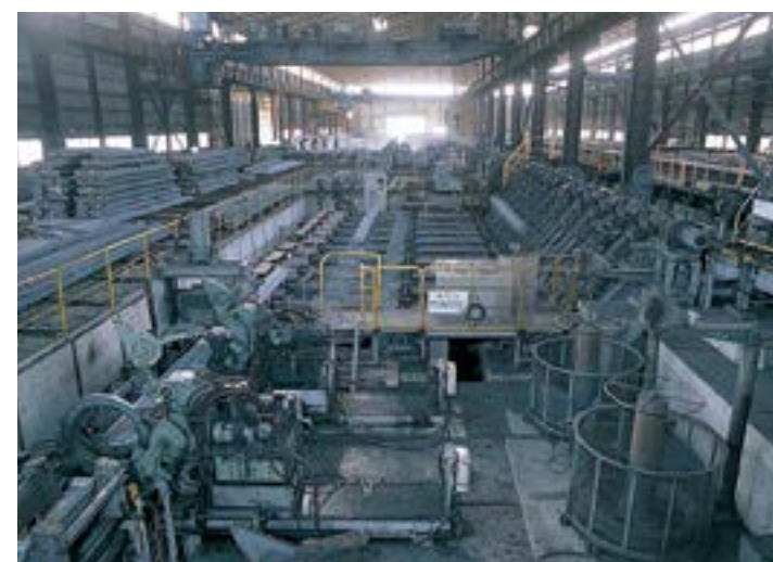
●全自動定尺切断結束(筑波工場)
